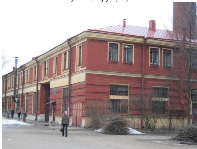
Помещение кафедры после реконструкции 1969 – 1970 г.г. (фото 2008 г.). Вид с той же точки, что и на предыдущем фото.
