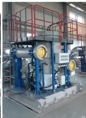
Тубодетандерные агрегаты АДКГ-10-20-УХЛ4 на СОГ КС-42 Ярынская МГ «Бованенково-Ухта»
