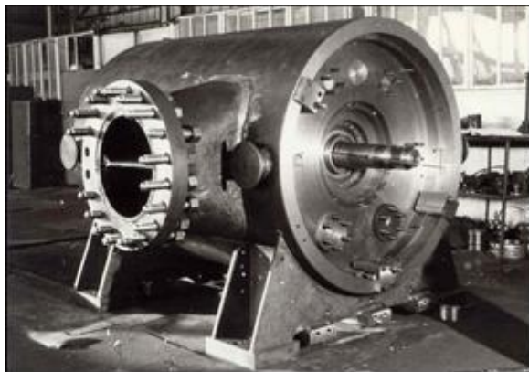
Двухступенчатый центробежный компрессор линейного газоперекачивающего агрегата 16 МВт (НПО «Искра» по г/д проекту Методом универсального моделирования)
