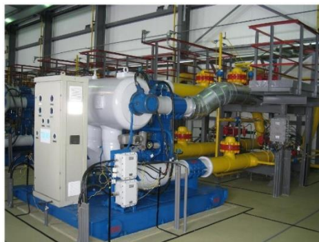
Турбодетандерный агрегат АДКГ-10 с компрессором ТК-3. Первый серийный агрегат на магнитных подшипниках
