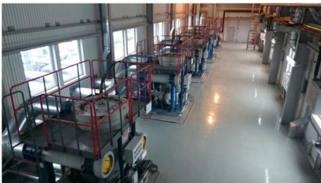
Тубодетандерные агрегаты АДКГ-10-20-УХЛ4 на СОГ КС-42 Ярынская МГ «Бованенково-Ухта»
